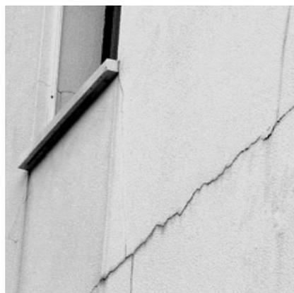
Figura 1 – Fissura horizontal devido à movimentação de origem térmica/higroscópica [3]
