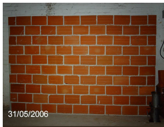
Figura 6 – Parede de alvenaria de bloco cerâmico.
