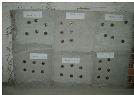
Figura 7 - Pastilhas metálicas coladas nas argamassas.
