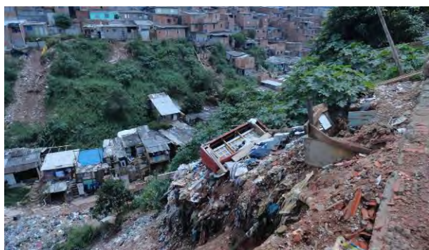
Figura 1 – Deslizamento de lixo e residências na comunidade Santa Madalena – São Paulo - SP.
