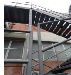
Figura 2 - Corrimãos Descontínuos nas Saídas de Emergência por Escadas.
