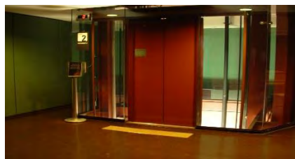
Figura 2 – Acesso ao elevador com piso tátil (Autores, 2015)
